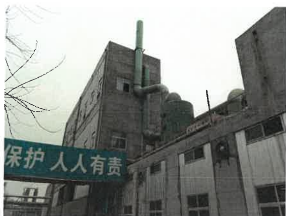
污泥脱水间排气筒（整改后）
