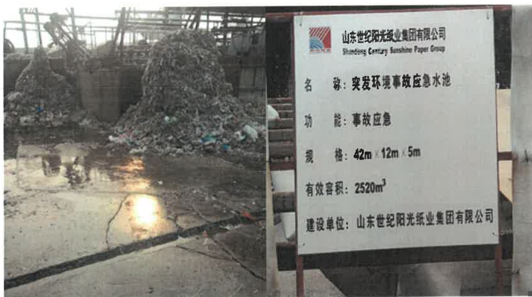
导流槽与事故水池
