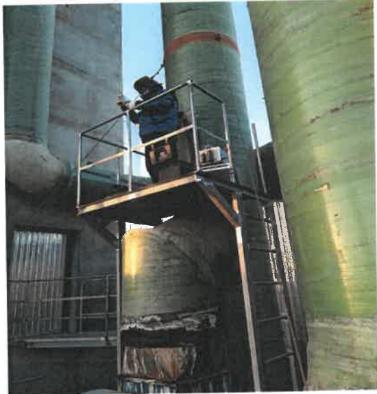
污泥脱水间排气筒
