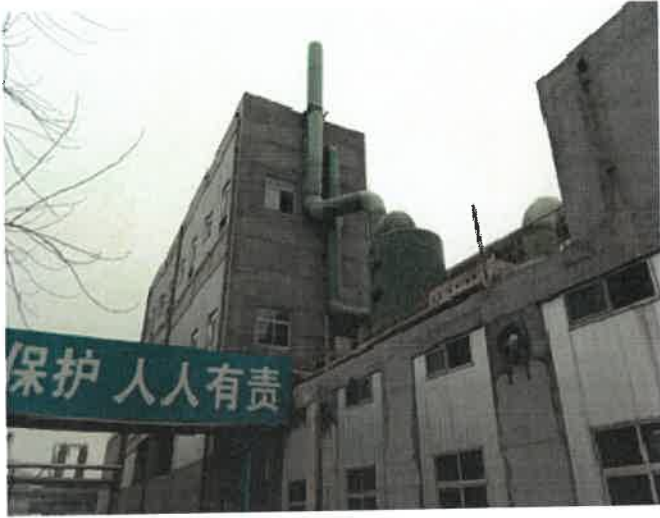
污泥脱水间排气筒（整改后）
