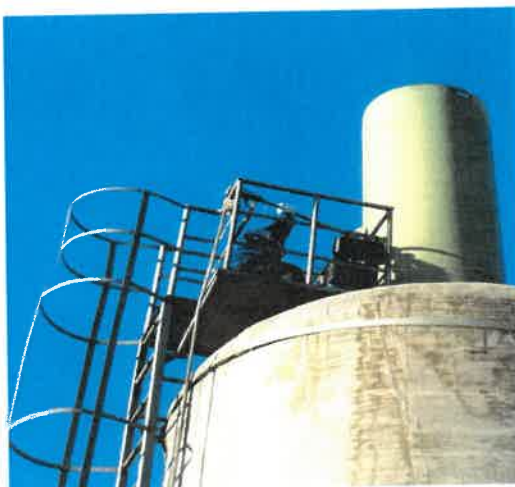
整改前污泥脱水间排气筒
