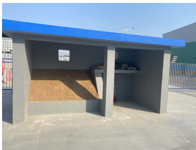
显华 110kV 变电站应急物资库
