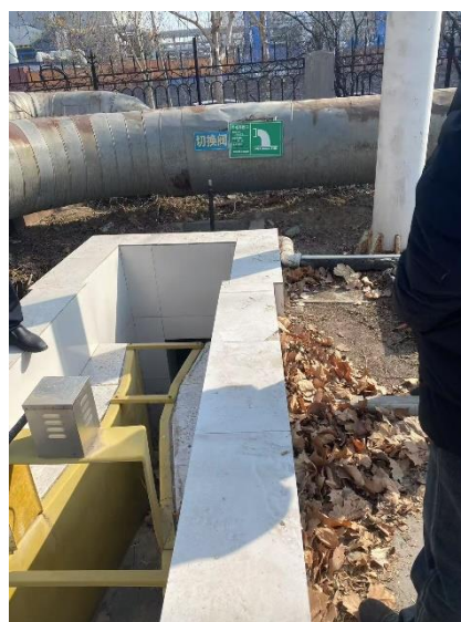
阳光王子厂区总雨水排口及切换阀
